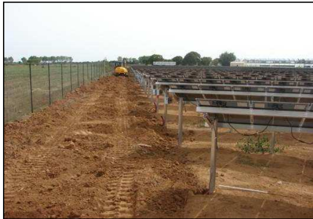
Illustration 212 : Recouvrement des tranchées
