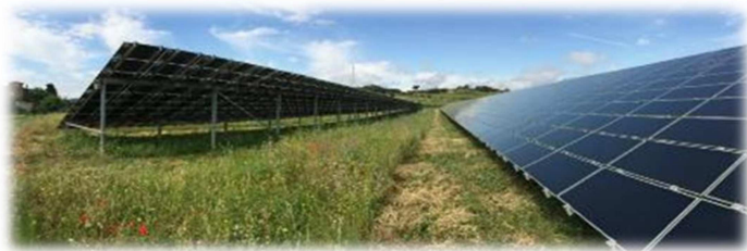
Illustration 229 : Exemple de fauche sur un parc photovoltaïque
